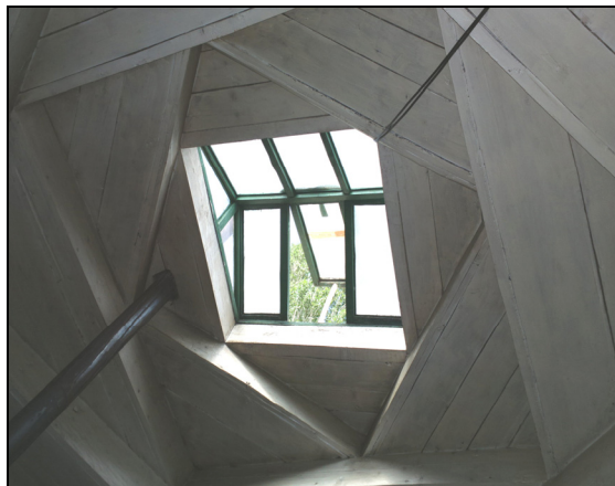
Рис. 3. Конструкция светового окна в доме жителя Миденшарва Алиберди Имумбердиева. Fig. 3. The light window in the house of Aliberdy Imumberdiev in the Midensharv.
