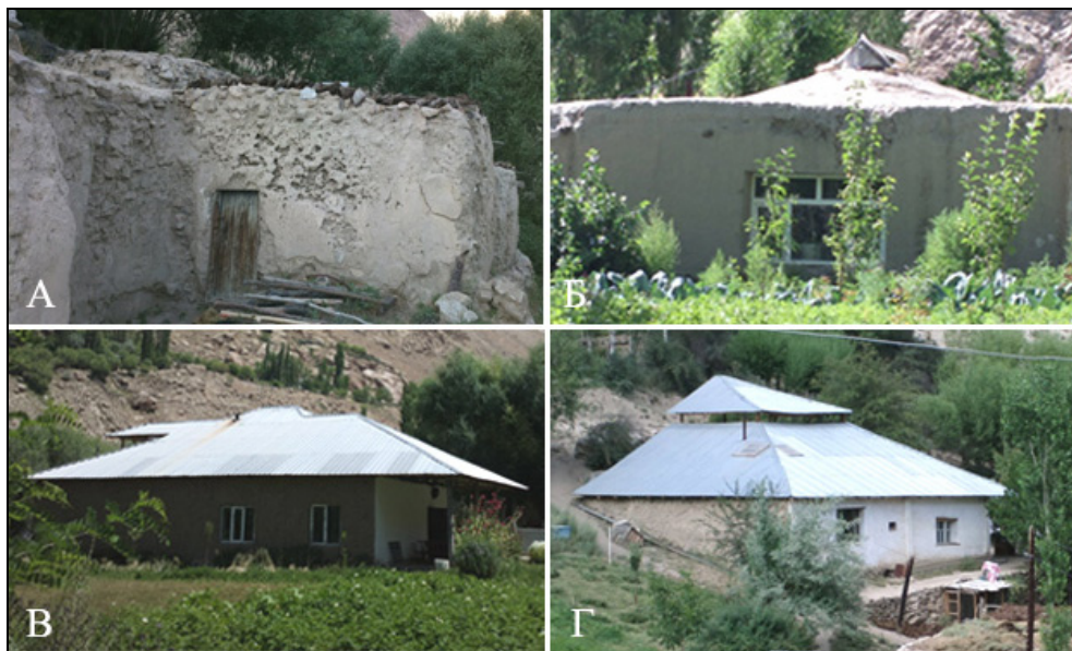
Рис. 4. Эволюция памирского дома в к. Миденшарв: А — традиционный памирский дом без окон с плоской крышей; Б — памирский дом с открытой крышей и пластиковым окном; В и Г — дома с пластиковыми окнами и современной металлической крышей.
